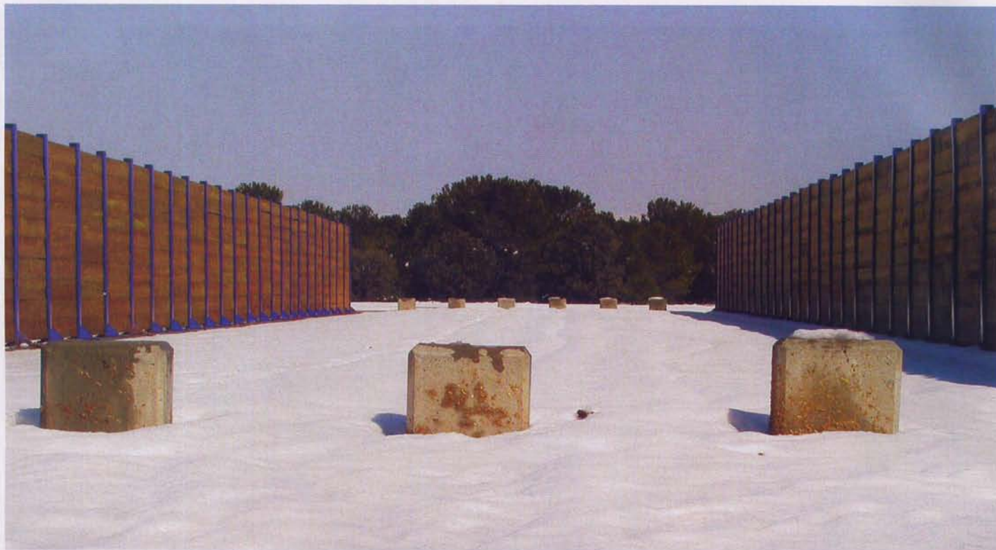
▲ Paso para lobo sobre una autovía en Castilla y León. Está flanqueado por paneles de madera, para que los animales no vean la calzada y se sientan confiados, y cerrado al tráfico rodado por pivotes (foto: Javier Talegón).
